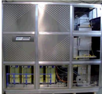
**Figura 15.** Vista de Pila de Combustible ICI Caldaie tipo Sidera 30 (ICI Caldaie) [45]
